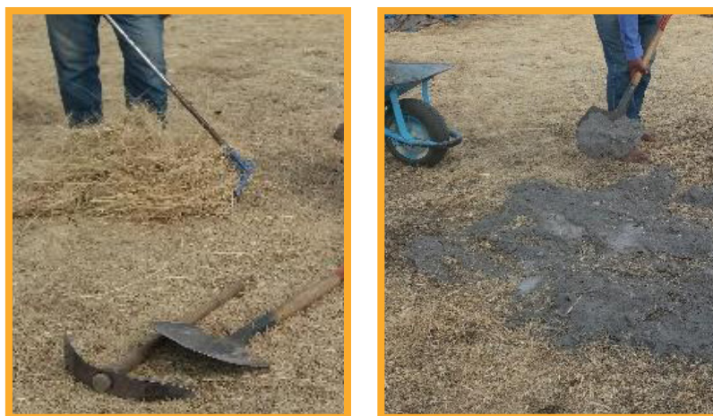
Figura 20. Colocación de capa aislante con ceniza
