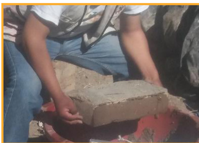
Figura 27. Remojo de las caras del adobe reforzado
