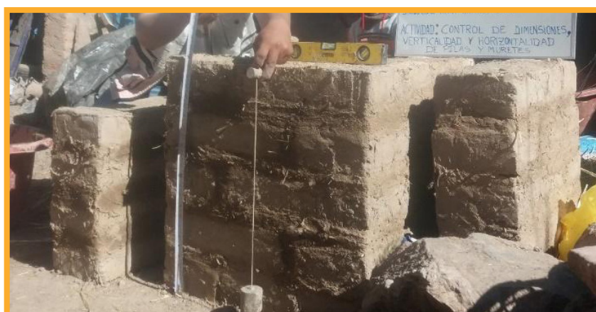
Figura 29. Verificación de la horizontalidad y verticalidad del murete
